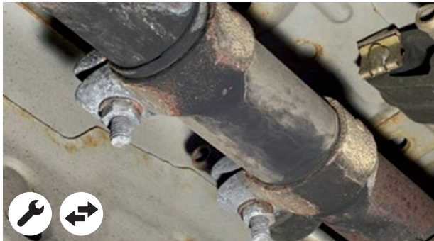
Presenza di perdite Ruggine
