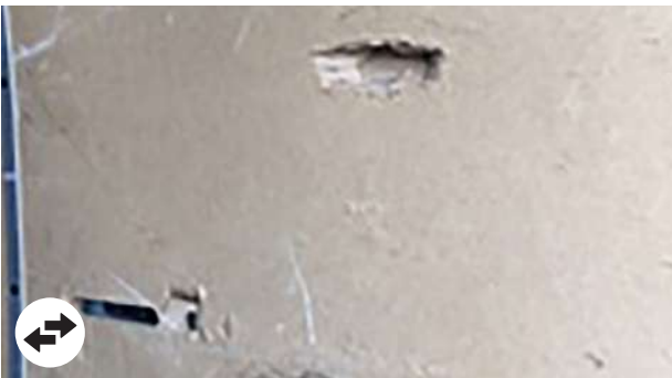
Protezioni interne in legno: Urti > di 2 cm, pannello strappato, pannello mancante (esclusi i pannelli superiori delle porte)
