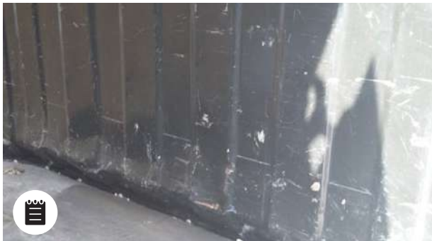
Deformazioni interne: Leggera deformazione senza perforazioni o tagli, tempo di riparazione ≤ 3 h
