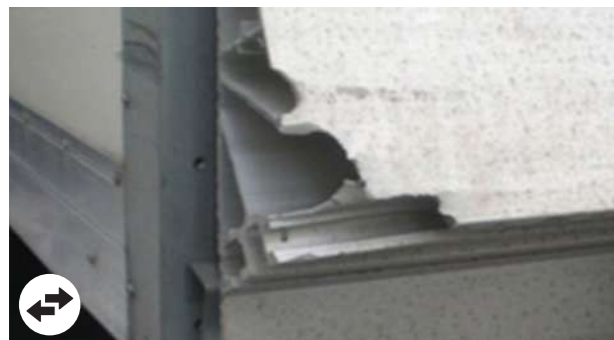
Sponda caricatrice: Deformazioni della piattaforma dalla riparazione antieconomica, rivestimento rotto o incompleto
