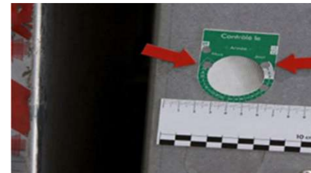
Sponda caricatrice: date di controllo scadute
