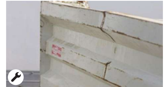
Deformazioni nelle sponde con tempi di riparazione > 1 h e se < di 10 cm
