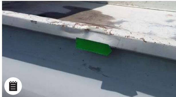
Graffi di lieve entità, deformazioni nelle sponde con tempi di riparazione \leq 1 h
