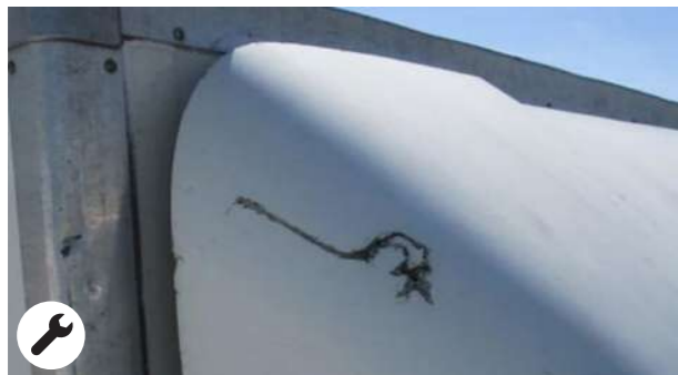
Carenatura del tetto e deflettore: riparazione Graffi economicamente conveniente
